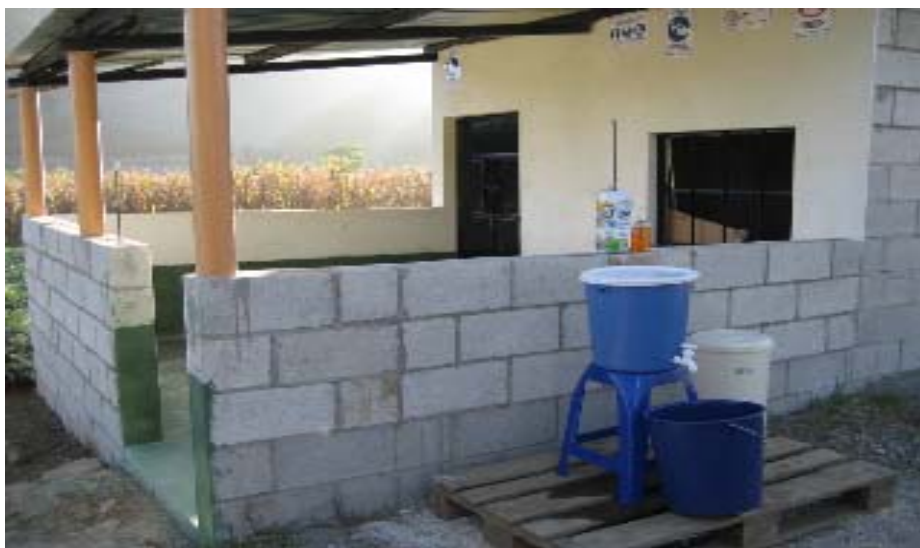
Fotografía de uno de los 15 centros de acopio de fresa, construidos y equipados con fondos del programa ACDPE en la Aldea Chimazat, Santa Cruz Balanyá, Chimaltenango; como parte del apoyo al proceso de certificación de la organización ASOCACH.
